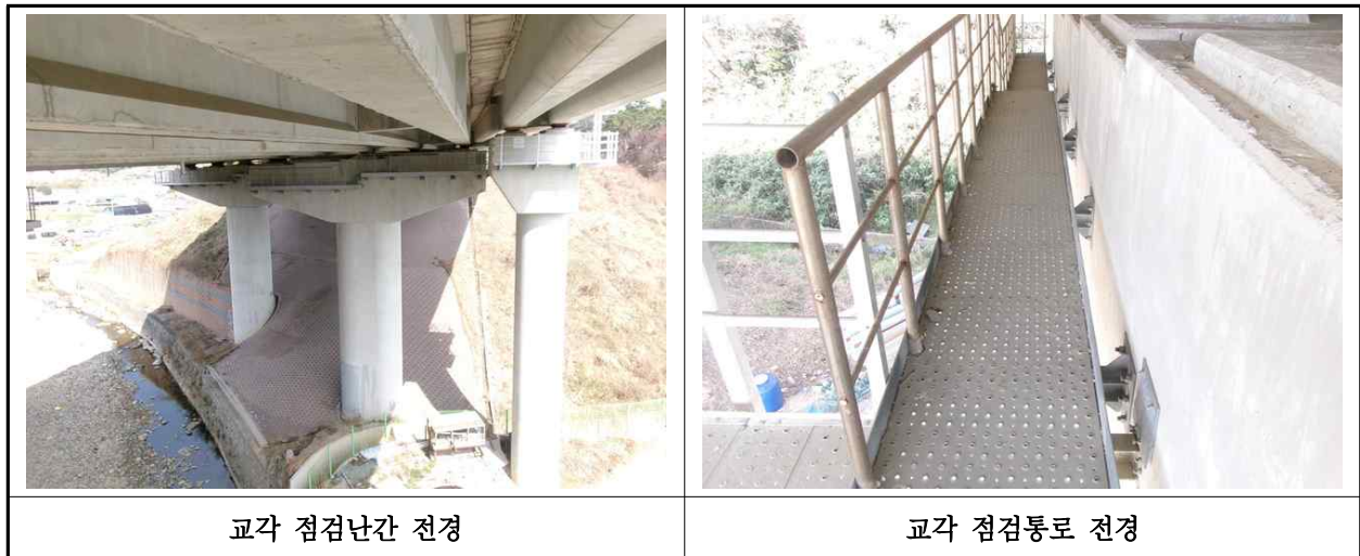
【사진 12.3.26】 교량 점검시설 전경
