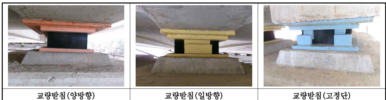
【사진 12.3.13】 교량반침 전경
