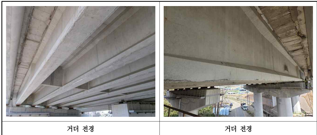
【사진 12.3.4】 거더 전경
