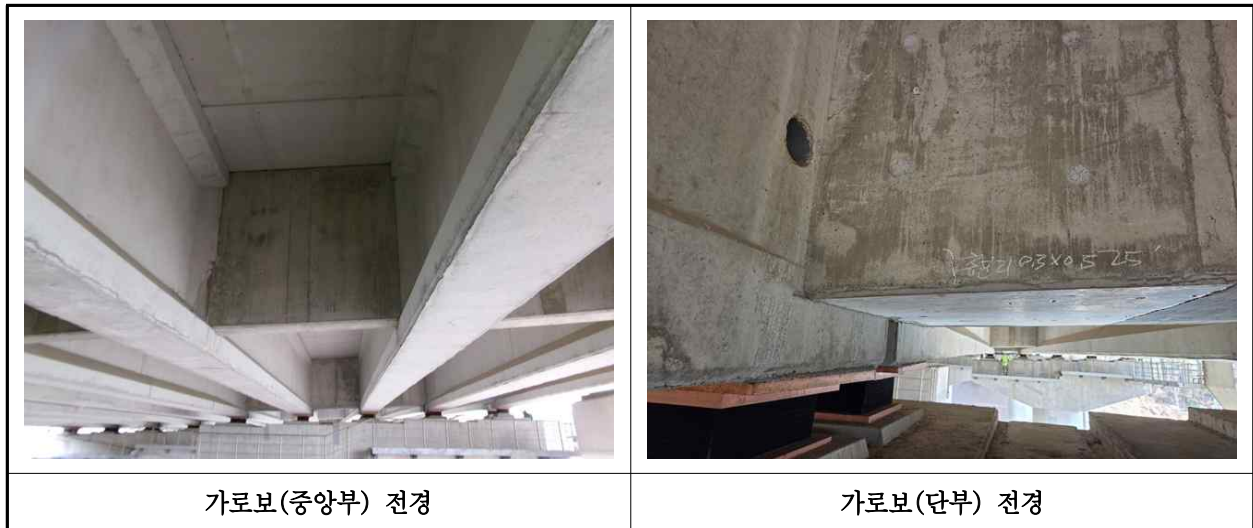
【사진 12.3.6】 가로보 전경
