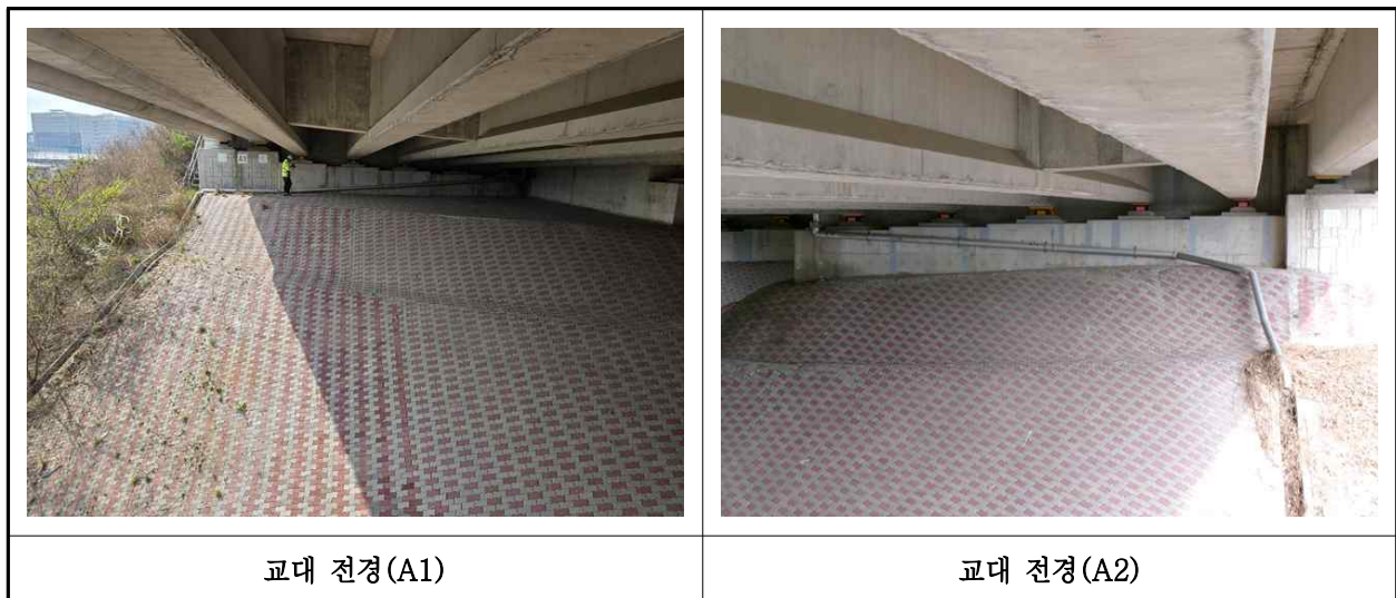
【사진 12.3.8】 교대 전경
