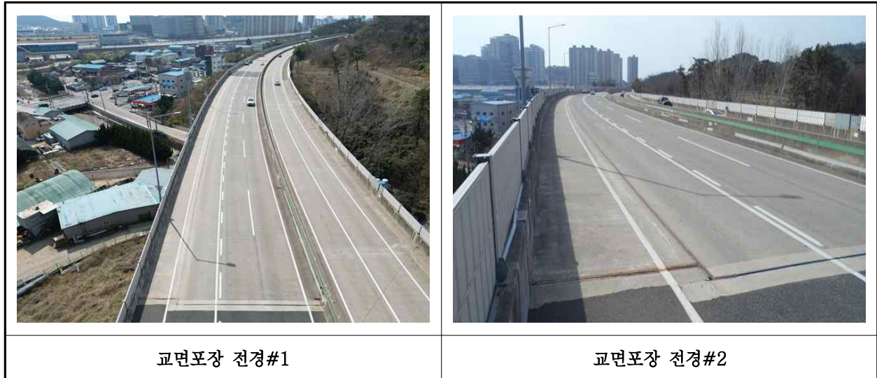
【사진 12.3.20】 교면포장 전경
