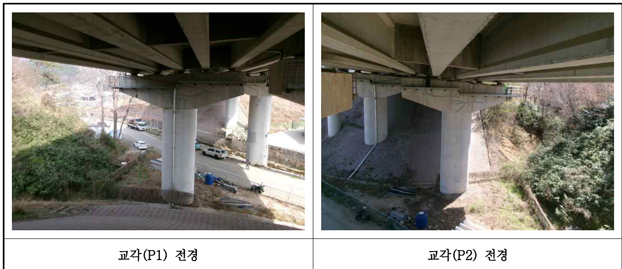
【사진 12.3.10】 교각 전경
