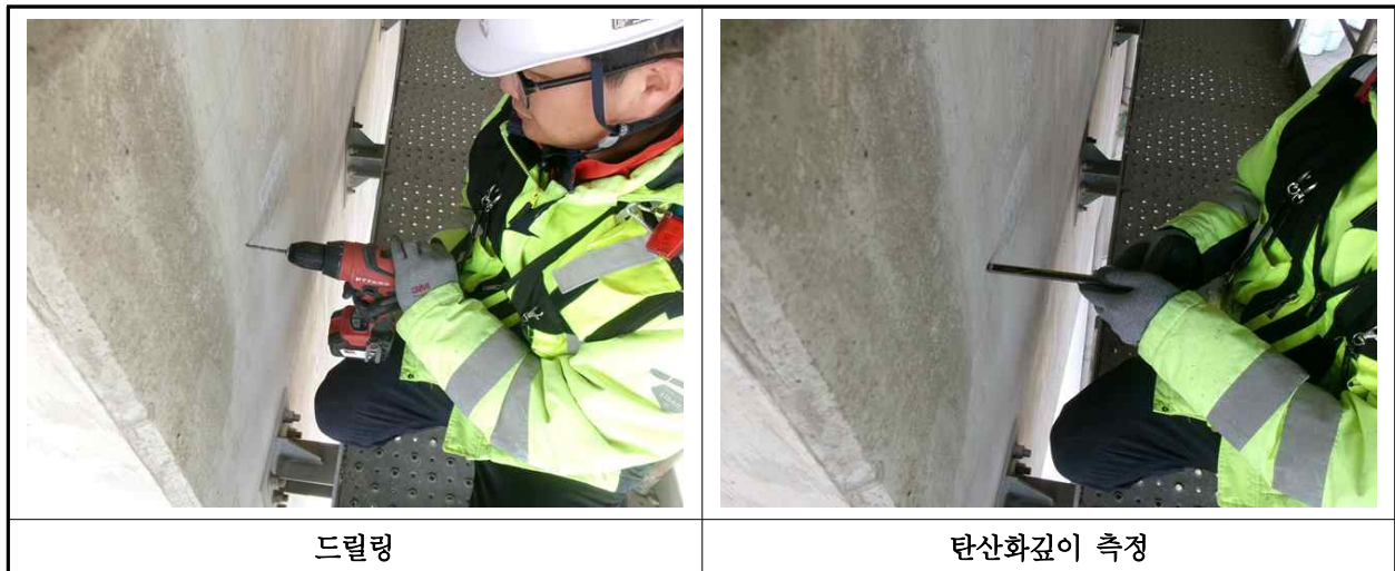
【사진 12.4.3】 탄산화 깊이 측정 현장사진
