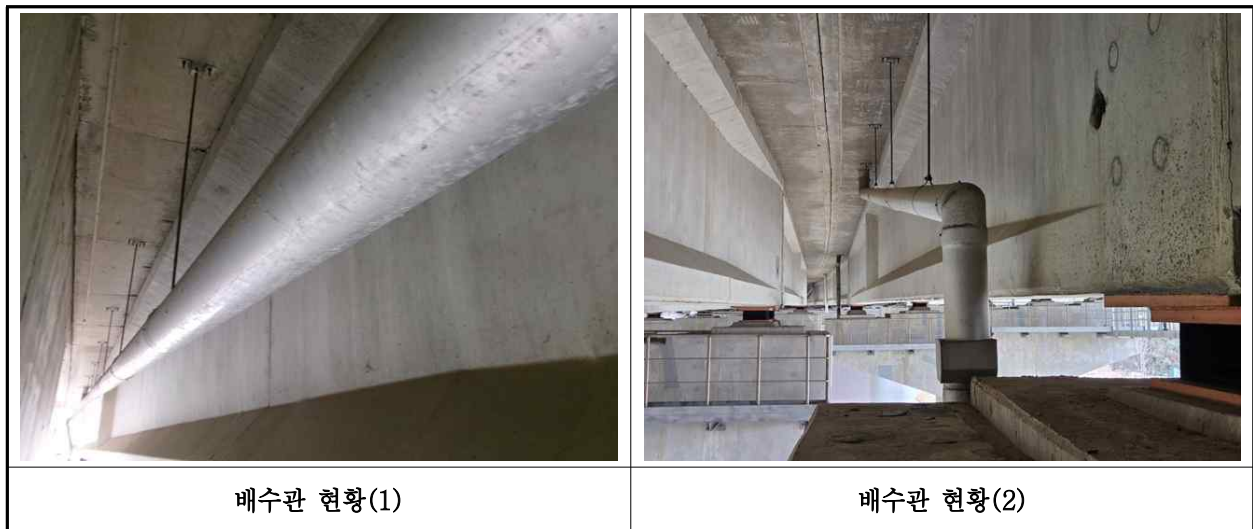
【사진 12.3.22】 배수시설 전경
