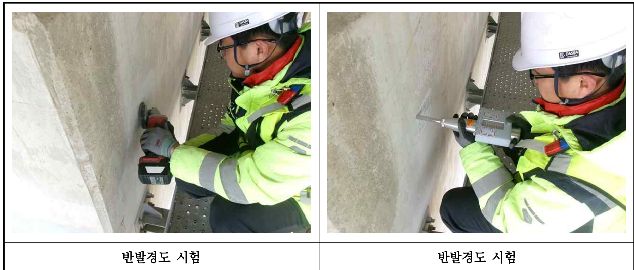
【사진 12.4.2】 반발경도시험 현장사진
