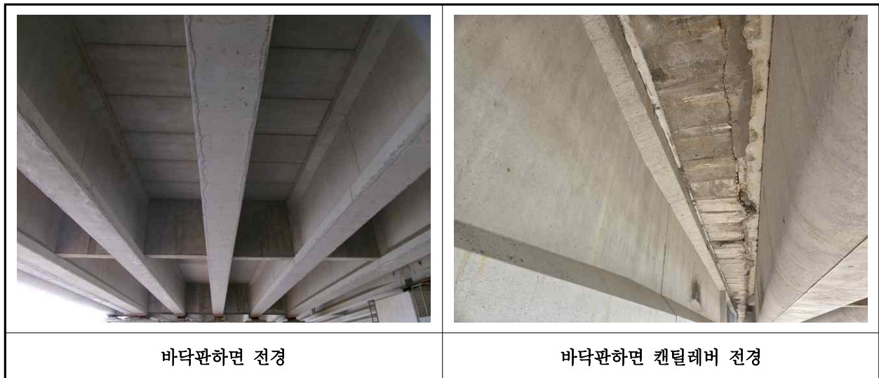
【사진 12.3.2】 바닥판하면 전경
