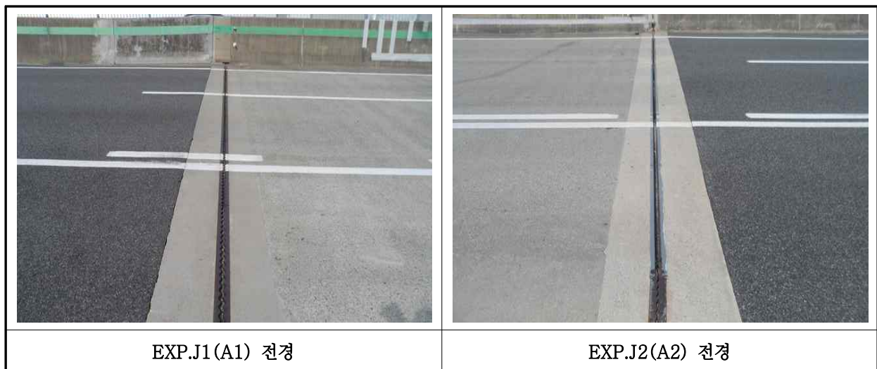
【사진 12.3.17】 신축이음장치 전경
