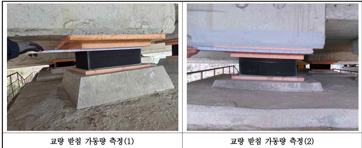
【사진 12.3.16】 교량받침 이동량 측정
